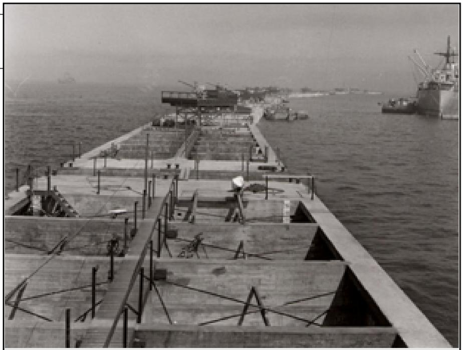
des navires à l'intérieur du port artificiel ainsi créé, on aménagea des pontons flottants avec des flotteurs couissant le long de piliers ancrés au fond de l'eau. *Ce principe innovant a été repris plus tard par les compagnies pétrolières pour l'aménagement de plateformes offshore.* Les pontons étaient reliés à la plage par des passerelles métalliques posées sur des barges.
